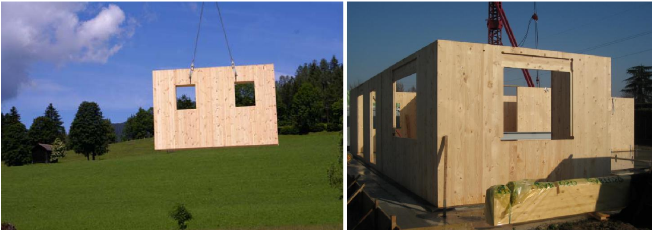
(sistema costruttivo con pannelli portanti prefabbricati tipo x-lam)
