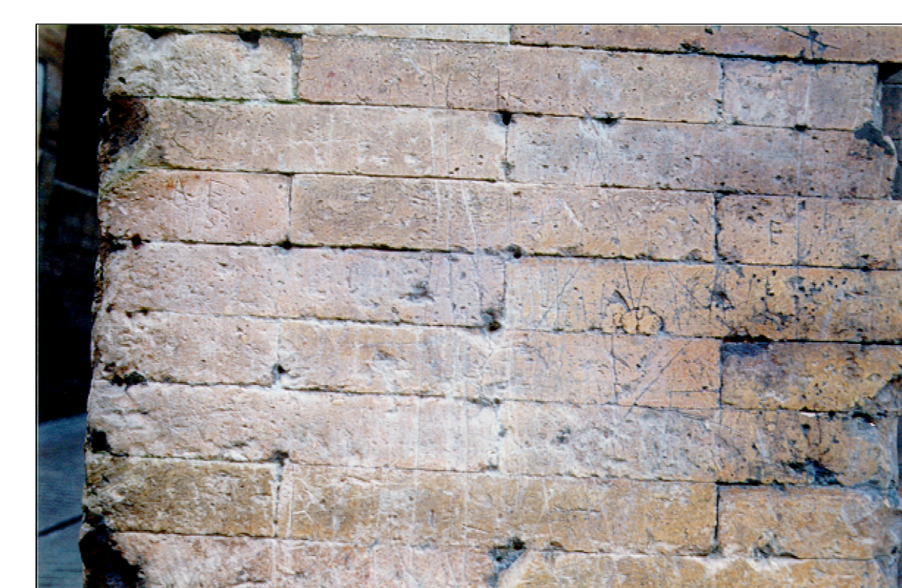
ESEMPIO DI VERO APPARATO MURARIO REALIZZATO IN MATTONE IN LATERIZIO A "FACCIA A VISTA". SI POSSONO NOTARE LE FUGHE QUASI INESISTENTI DOVUTE ALLA MALTA DI COLLEGAMENTO TRATTENUTA DALLE FACCE CONCAVE DEI MATTONI TRAFILATI, APPPOSITAMENTE REALIZZATI PER L'EFFETTO "A VISTA"
