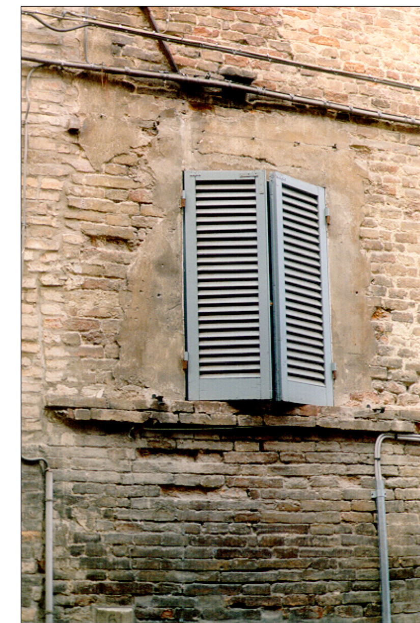
ESEMPI DI FORTE DEGRADO DELLE FACCIATE MOLTO PROSSIME ALLA COMPLETA SCOMPARSA DEGLI ORIGINARI INTONACI E DI TUTTI GLI APPARATI COMPOSITIVI-DECORATIVI.
