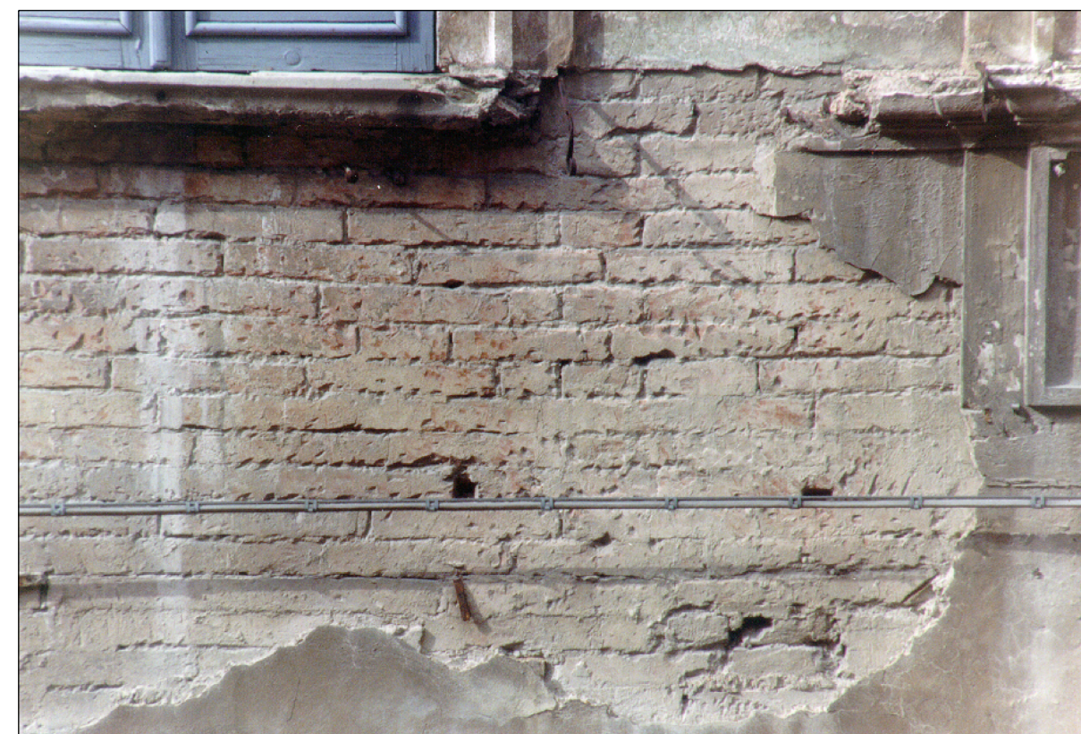
AMPIE ZONE DI INTONACO A CALCE ORIGINARIO COLLATE, CON ESSE ANCHE GLI ELEMENTI PLASTICO-DECORATIVI.
