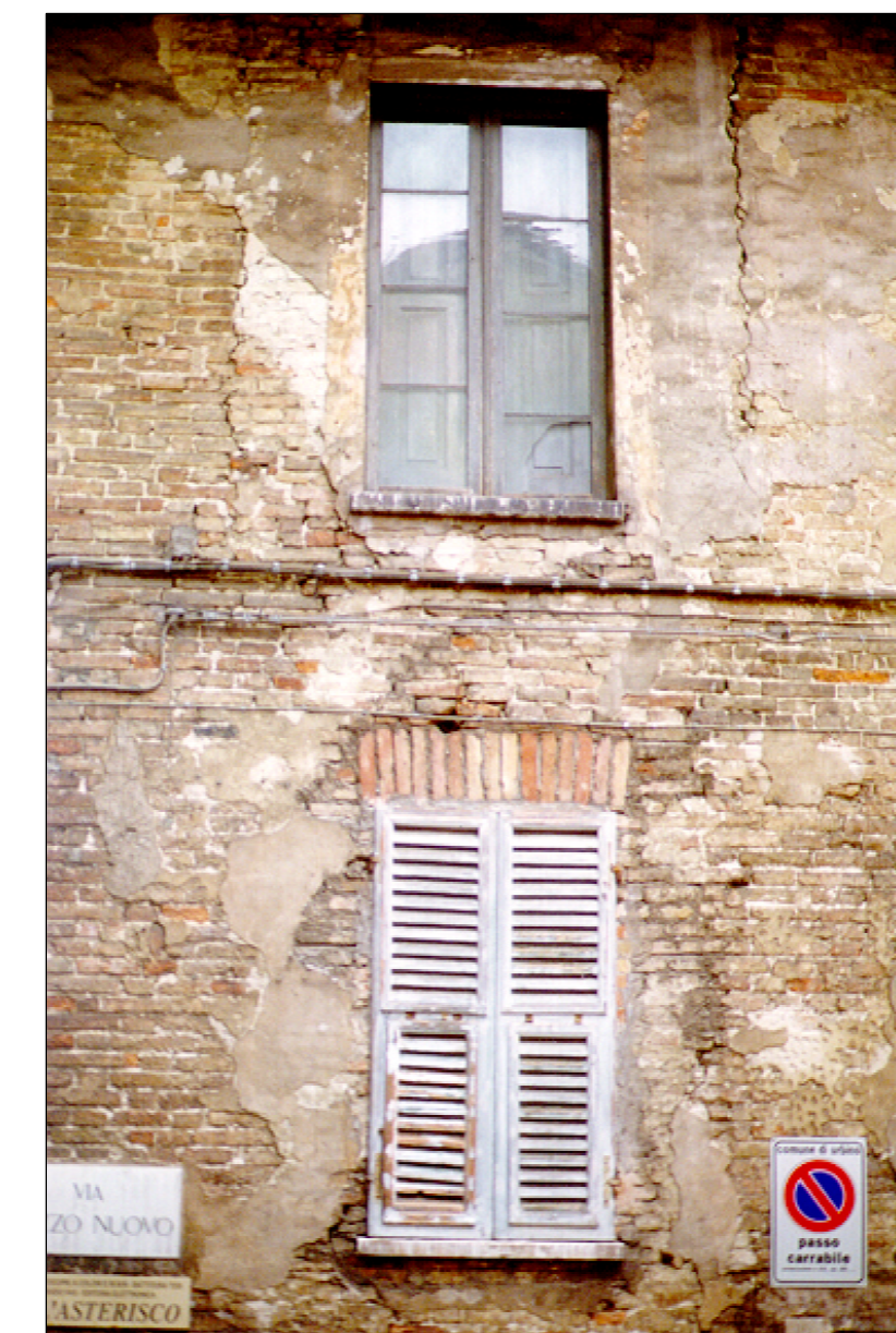
ESEMPI DI FORTE DEGRADO DELLE FACCIATE MOLTO PROSSIME ALLA COMPLETA SCOMPARSA DEGLI ORIGINARI INTONACI E DI TUTTI GLI APPARATI COMPOSITIVI-DECORATIVI.
