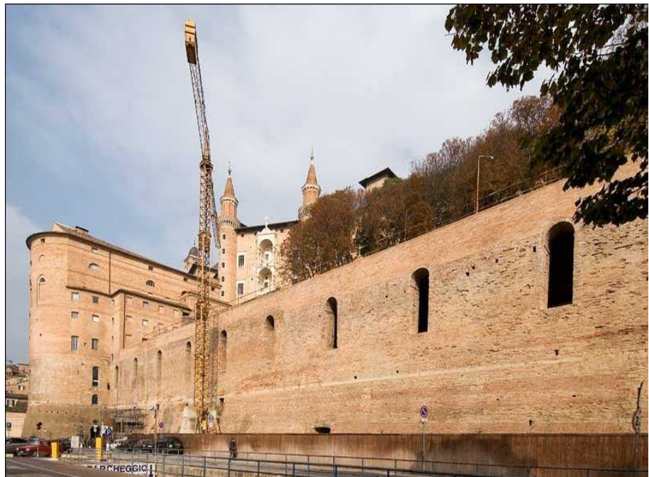
Ex Stalle Ducali. La Data, 1999. Immagine della data al momento dell'installazione del cantiere.
