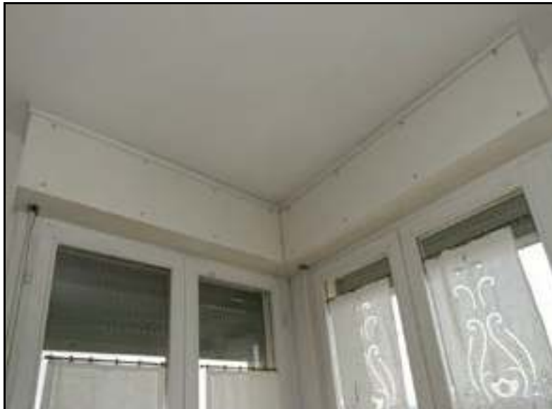
Ponte termico dovuto a cassonetto tapparella avvolgibile
