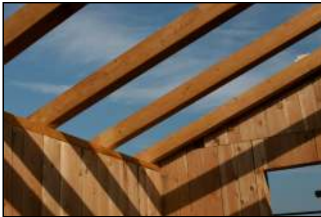
Fase di realizzazione di casa in legno prefabbricata con pareti massicce a tavole inchiodate
