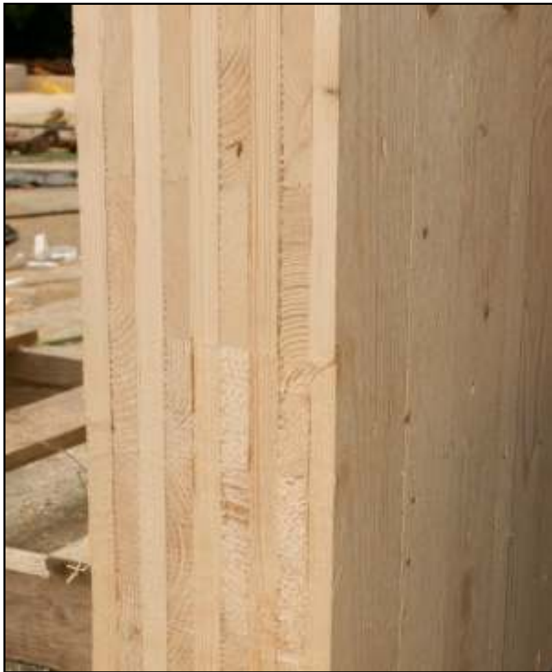
Particolare dalla tecnica costruttiva a tavole inchiodate
