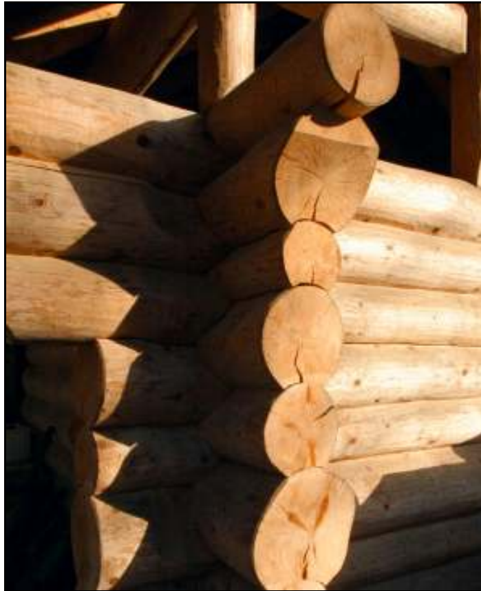
Particolare dalla tecnica costruttiva a tronchi sovrapposti
