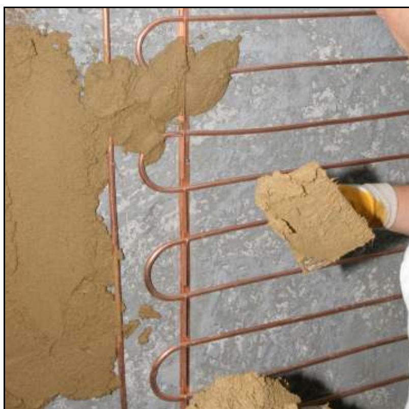
Intonaco di argilla con riscaldamento a parete. La soluzione migliore per il Comfort Termico
