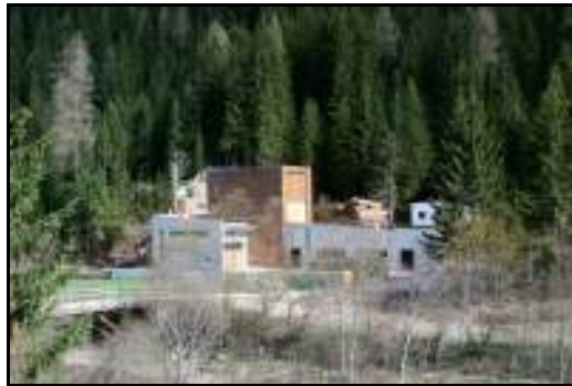
Centrale termica a condensazione per teleriscaldamento di un paese in Sud Tirolo –Alto Adige Fonte utilizzata: legname
